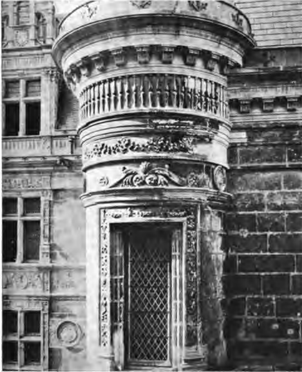
Fig. 91. — Fenêtre d'une tourelle à l'Hôtel de Pincé. Décoration du chambranle comparable à celle des fenêtres du Palais Ducal de Venise.
